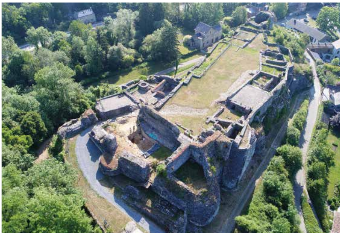
Prise de vue aérienne du château de Moha et localisation de la zone de fouille. J. Adam © Château de Moha
