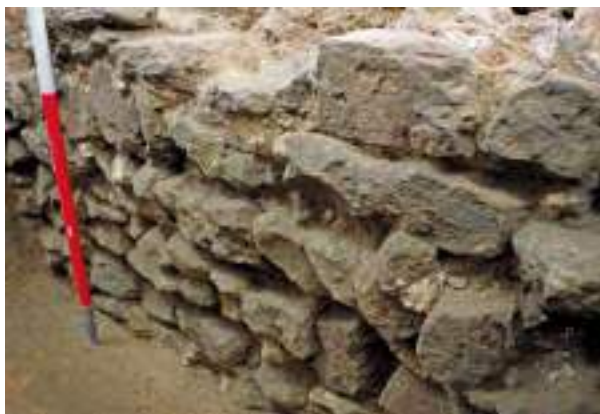
Fig. 2 Fundament zuidmuur van het romaans schip.
