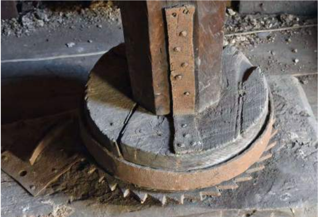
Fig. 3 Détail du cabestan à crémaillère (©AwAP).
