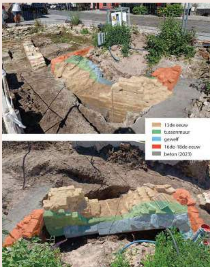
Fig. 1 Fasering van de bakstenen structuur.
