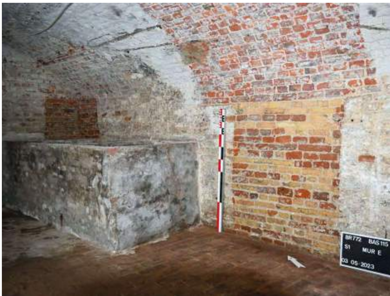
Fig. 2 Mur support oriental et départ de voûte de la cave du secteur 1 de la maison rue du Marché-au-Charbon 37 montrant une maçonnerie homogène constituée de briques de production locale et de briques d'importation © urban.brussels -ULB
