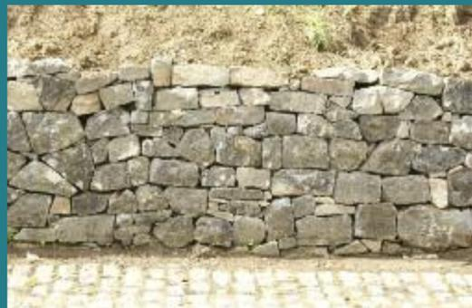
A l'aide de cales (petites pierres), il est indispensable d'immobiliser chaque pierre posée sur le mur avant de poser la suivante. Les pierres ne doivent plus bouger.
